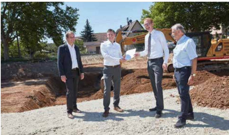
(v.l.n.r.) Jörg Straub, Marc Ullrich, Bürgermeister Thomas Gedemer und Gerhard Kiechle beim Spatenstich
