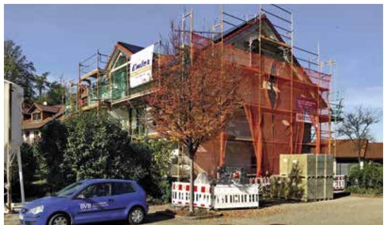
Energetische und heiztechnische Modernisierung der Haydnstraße 5
