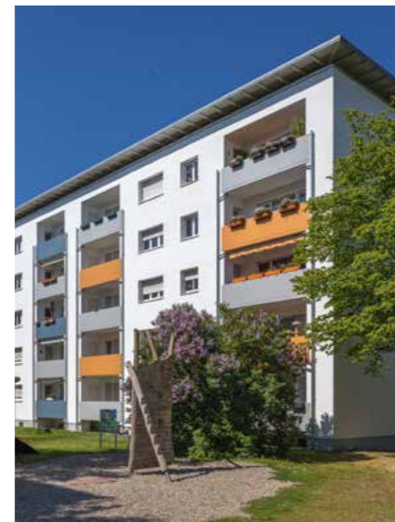
Wilmsdorfer Straße 8-24, Freiburg
