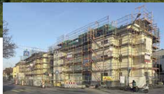
Noch herrscht reger Betrieb auf der Baustelle an der Basler Landstraße.
