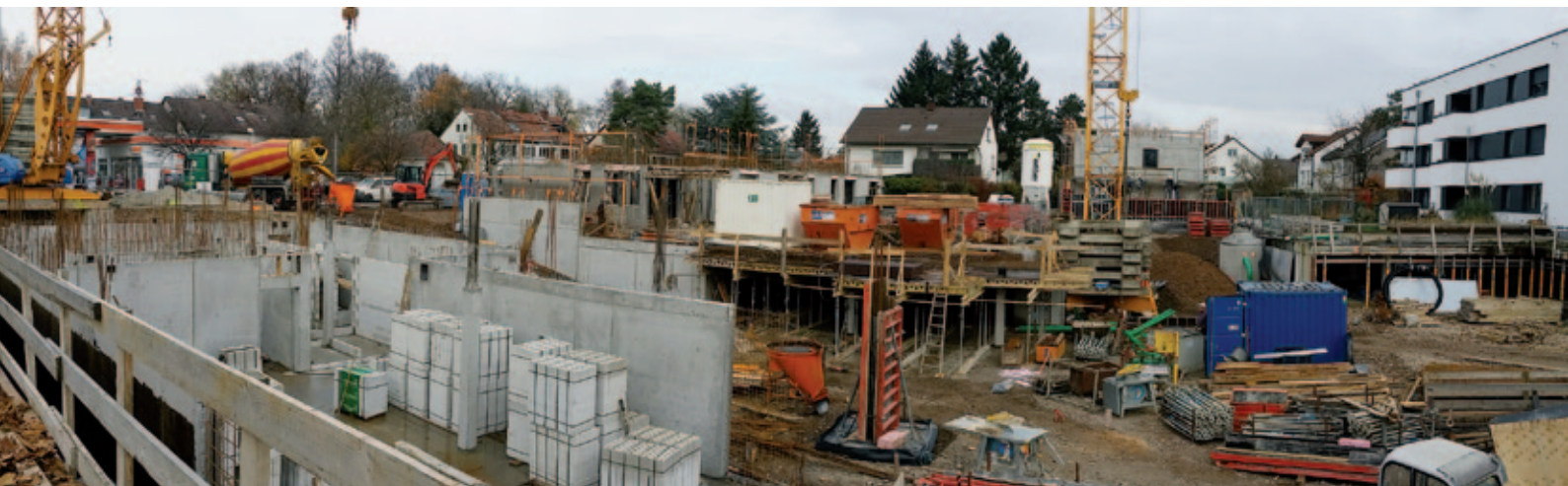
Blick von der Elsässer Straße: Links im Vordergrund Haus D, die fünf Reihenhäuser im Hintergrund, bereits fertiggestellt Haus A rechts.
